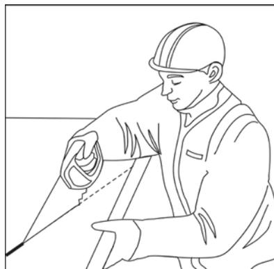
Рисунок 6.1 – Раскрой теплоизоляционных плит с использованием ножовки ручной
