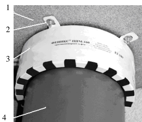
1 – перекрытие; 2 – крепление; 3 – муфта; 4 – труба
