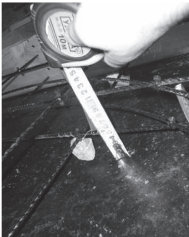
Рисунок 6.3 – Фрагменты арматурных каркасов из базальтопластиковых стержней, уложенных в опалубочную форму дорожной плиты с контролем их геометрических параметров
