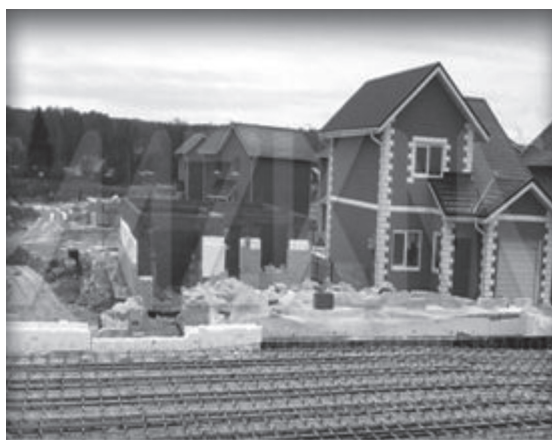
Рисунок 8.3 – Применение АНК для армирования фундаментной плиты 1)
