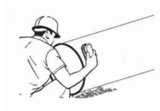
Рисунок Б.1 – Очистка поверхности трубы
